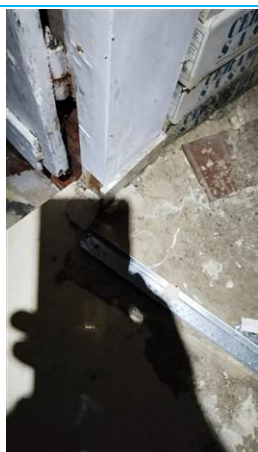
Matériaux : ZPSO-005 Prélèvement : P005 Description : Colle de carrelage Localisation : Rez de chaussée - entrée Résultat : Absence d'amiante
