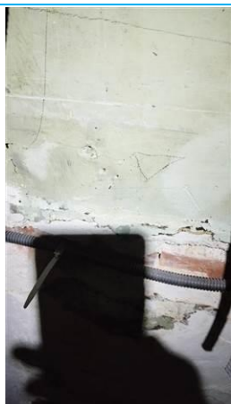
Matériaux : ZPSO-003 Prélèvement : P003 Description : Enduit à base de plâtre projeté Localisation : Rez de chaussée - cuisine 1 Résultat : Absence d'amiante
