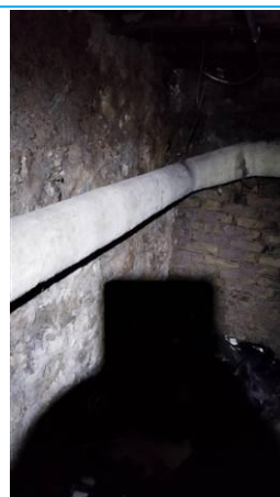
Matériaux : ZPSO-012 Prélèvement : P012 Description : Joint d'assemblage Localisation : Sous-Sol - cave Résultat : Absence d'amiante
