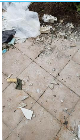
Matériaux : ZPSO-025 Prélèvement : P025 Description : Colle de carrelage Localisation : Rez de chaussée - terrasse Résultat : Absence d'amiante
