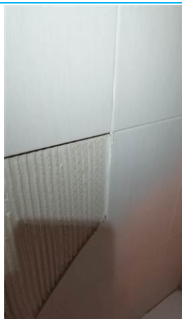
Matériaux : ZPSO-019 Prélèvement : P019 Description : Colle de faïence blanche Localisation : 1er étage - sdb Résultat : Absence d'amiante
