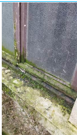
Matériaux : ZPSO-027 Prélèvement : P027 Description : Joint de mastic de vitrage (notamment châssis aluminium) Localisation : Rez de chaussée - dépendances Résultat : Absence d'amiante
