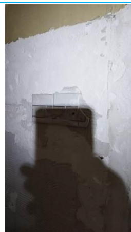
Matériaux : ZPSO-008 Prélèvement : P008 Description : Colle de faïence Localisation : Rez de chaussée - ch 1 Résultat : Absence d'amiante
