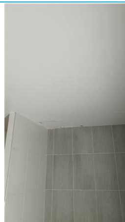
Matériaux : ZPSO-020 Prélèvement : P020 Description : Bandes calicot Localisation : 1er étage - sdb Résultat : Présence d'amiante
