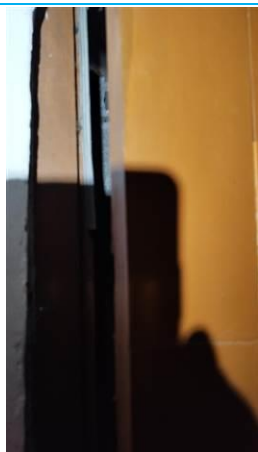
Matériaux : ZPSO-007 Prélèvement : P007 Description : Garniture de friction sur porte entrée Localisation : Rez de chaussée - entrée Résultat : Absence d'amiante
